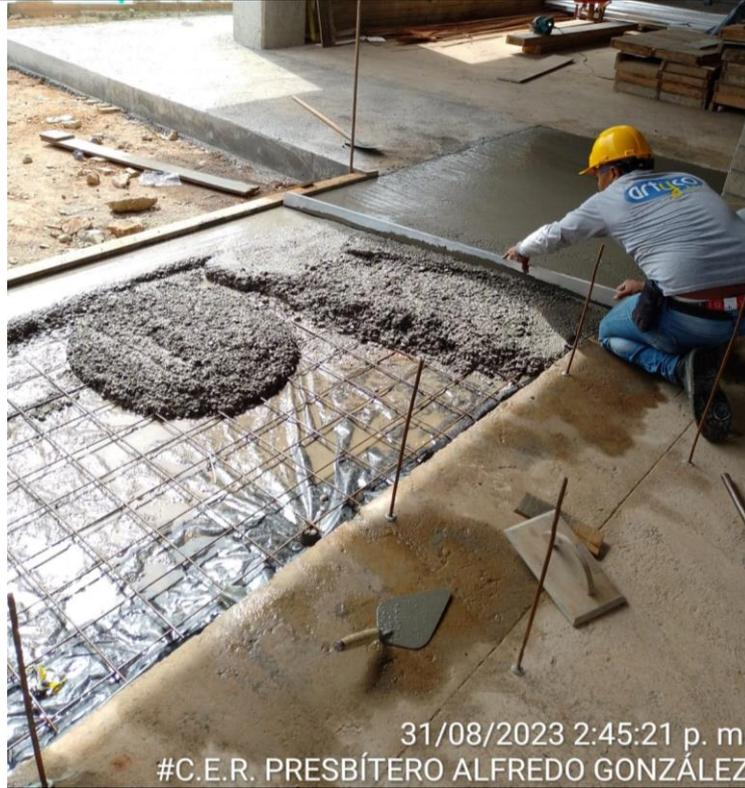
**Foto 3. Avance de Obra:** Vaciado de andenes perimetrales.
