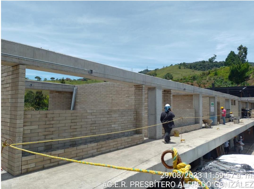
**Foto 1. Avance de obra:** Mampostería en segundo nivel, bancas y tubería eléctrica.
